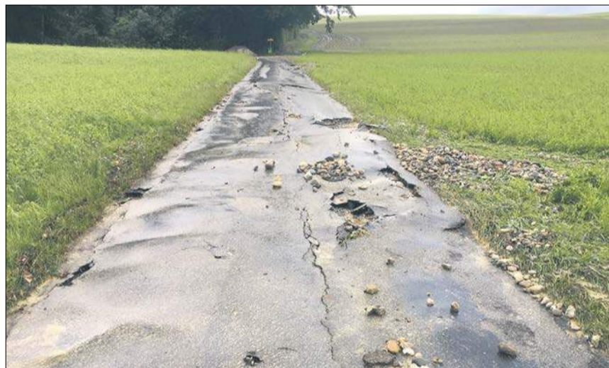
Fliesst in kurzer Zeit viel Wasser ab, nehmen Felder und Strassen Schaden (hier im Kanton Bern). Für die Prävention braucht es Zusammenarbeit.
