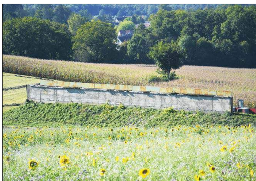
Im unteren Teil des Gebiets bildet der Kugelfang eines Schiessstands für abfließendes Wasser ein Hindernis und wird Teil der Retentionsplanung.
