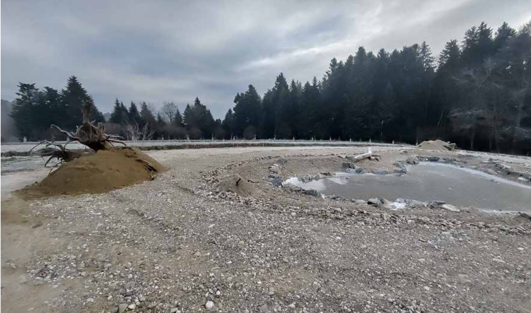
Umfangreiche Aushubarbeiten auf dem Natur Gut Katzhof.
